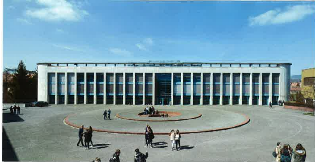
Vue de la barre horizontale du T que forme le collège construit dans les années 1990.
