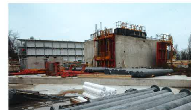
Un béton de type 2 est utilisé pour les parois intérieures. Les murs extérieurs sont réalisés avec des agrégats issus du concassage du béton de l'ancien ouvrage.
