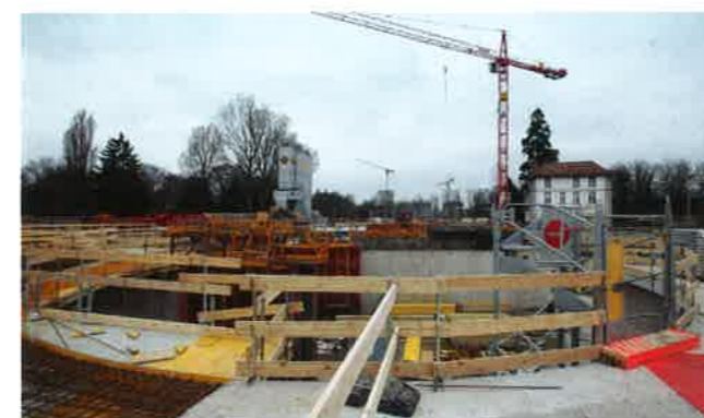
Complexe, la nouvelle construction présente de nombreuses circularités. Ici, l'escalier central.
