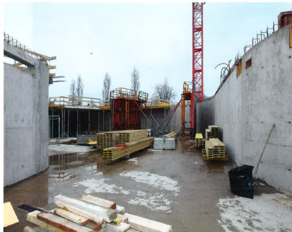
Les espaces intérieurs du sous-sol sont en béton de type 2, dont la qualité est remarquable.
