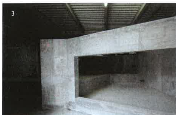
2 et 3. Des aquariums de diverses dimensions sont construits directement en béton ou réalisés en atelier.
