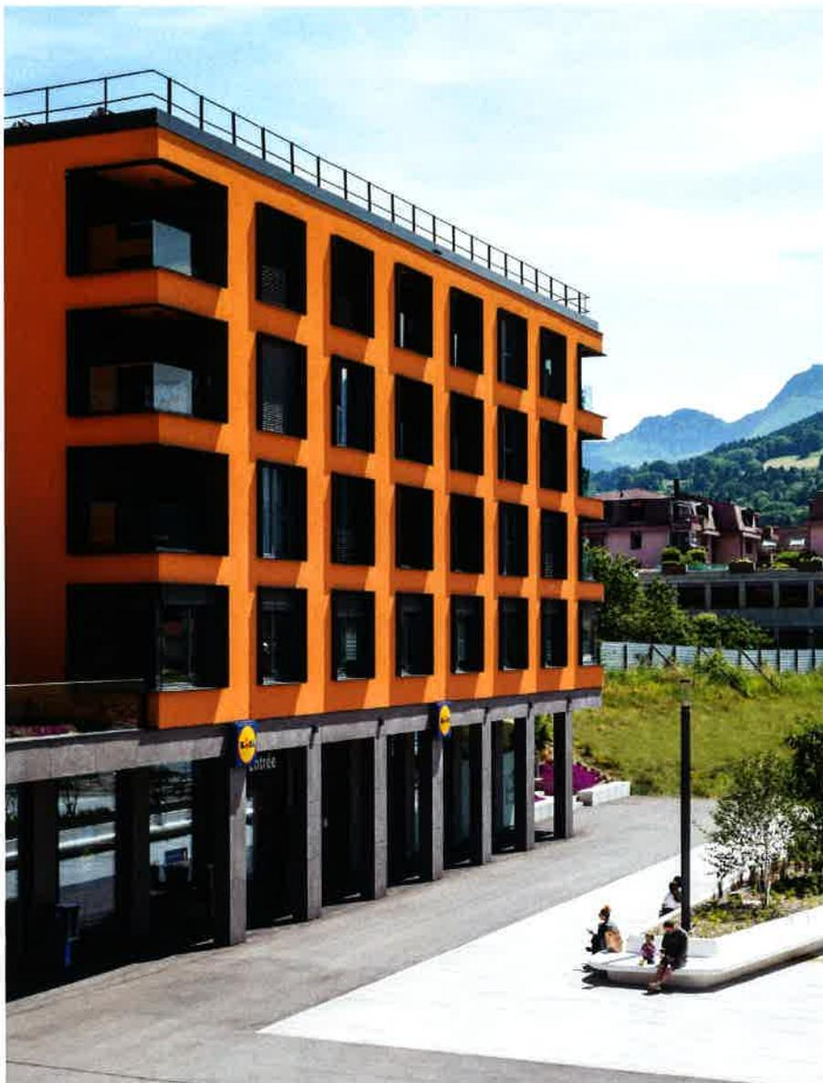
Le projet a utilisé la technologie BIM (Building Information Modeling) pour modéliser toutes les étapes de la construction, depuis les coffrages jusqu'aux armatures. Les bâtiments sont construits en béton armé, avec une superposition de planchers-dalles reposant sur des colonnes et murs porteurs. Les finitions extérieures alternent entre dalles minérales et enduits colorés, tandis que les intérieurs offrent des logements lumineux et fonctionnels avec des matériaux nobles.
