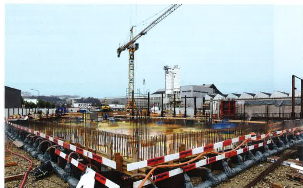
En haut, le bétonnage de la future salle de sport triple, au milieu, le radier et, en bas, l'enceinte de palplanches avec le système de wellpoint.
