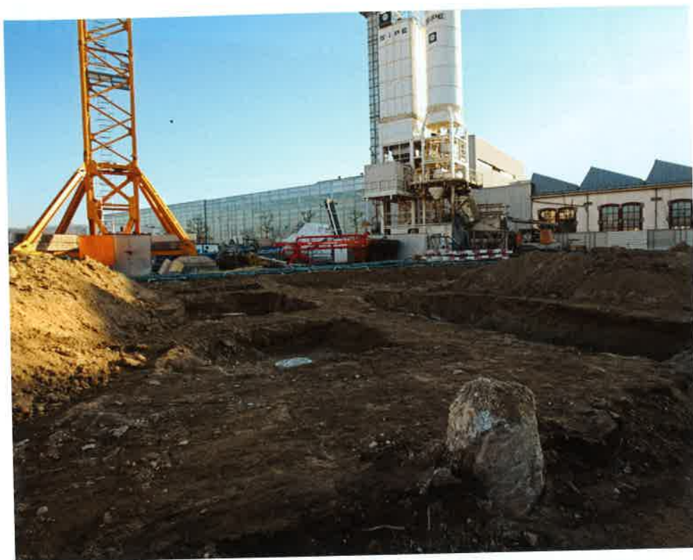
Le sol, très meuble, a été la principale difficulté du chantier.
