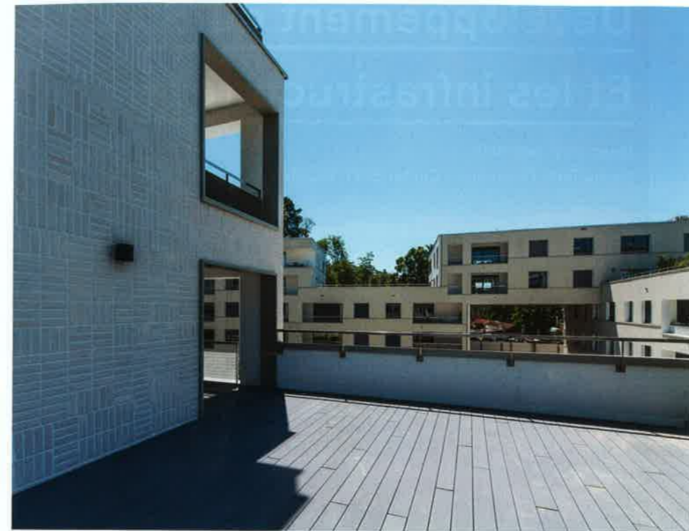
En contraste avec les façades en bois donnant sur la cour intérieure, les façades orientées sur l'extérieur de l'îlot sont revêtues de briquettes.
