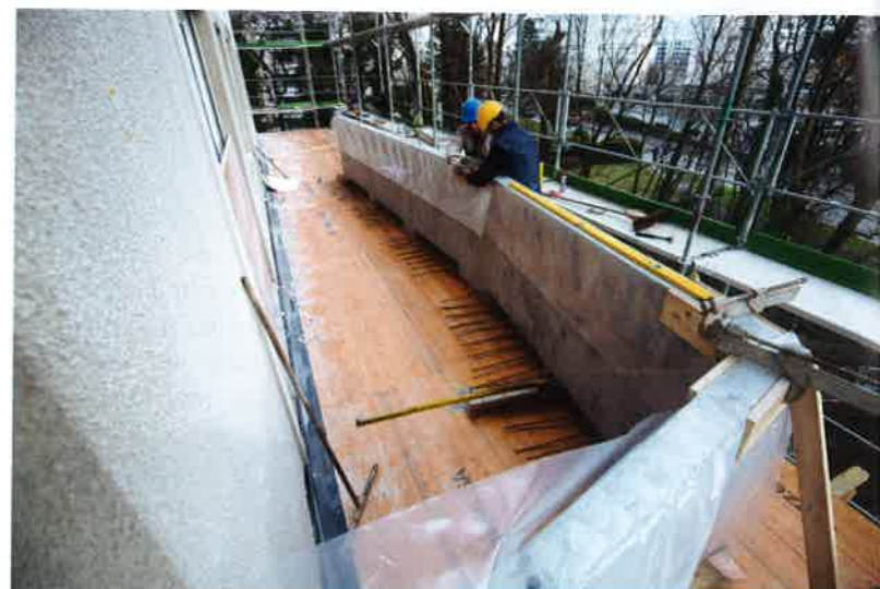
Photo de gauche, les balcons sont descendus dans la tour d'échafaudage par le grutier. Un travail de précision avec une marge de 30 cm de chaque côté. Ci-dessus, un petit balcon avant montage, les portes-fenêtres condamnées et la pose d'un grand parapet.
