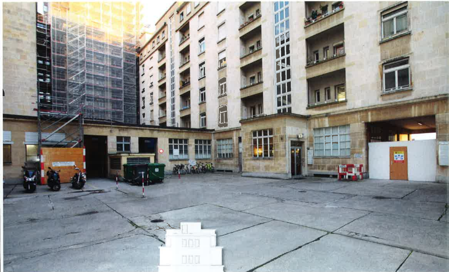
Vue de la cour intérieure: il n'est pas prévu, pour l'instant, de rénover les ailes de l'ensemble.
